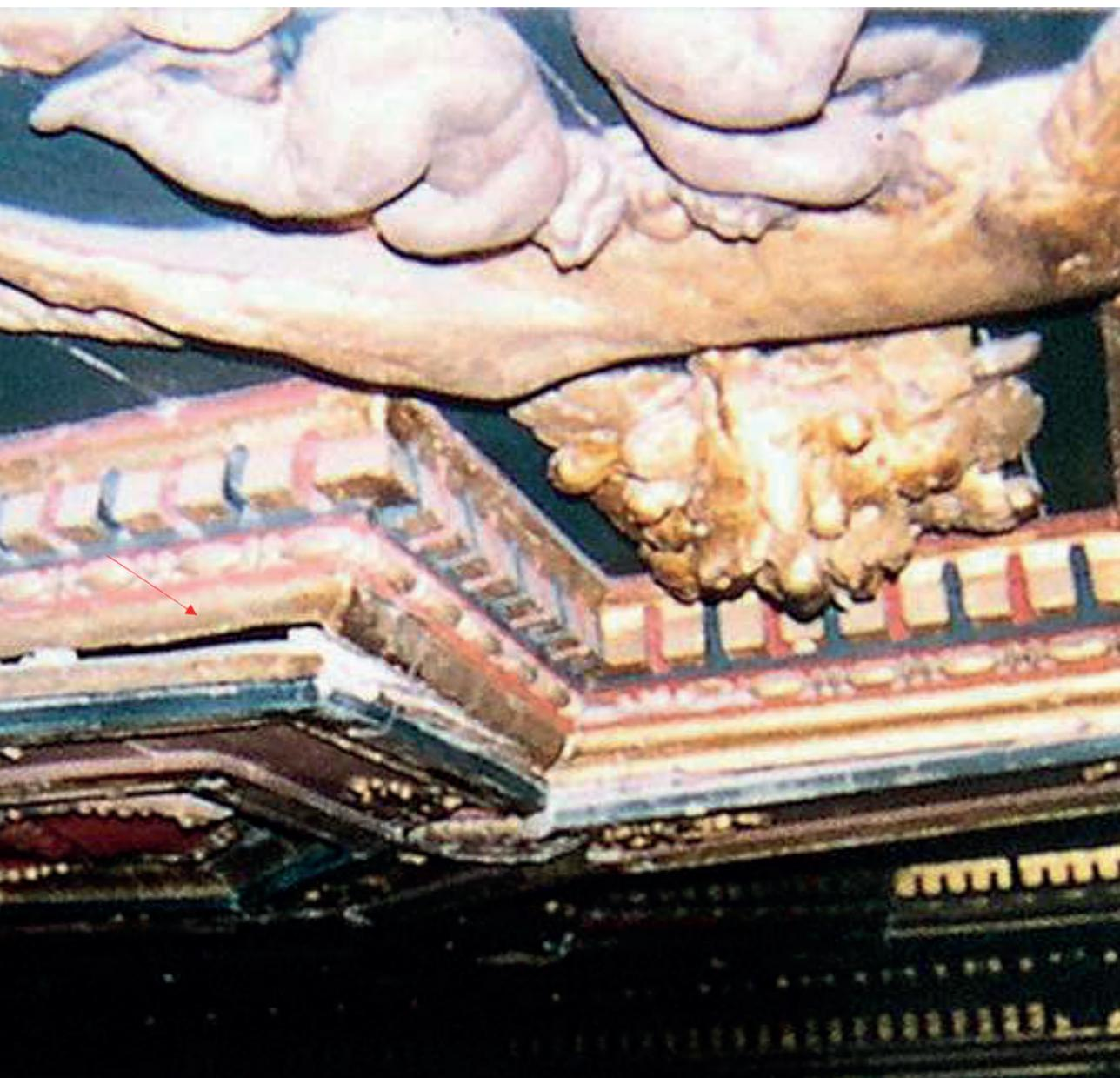
Figura 2. - I musei capitolini: soffitto della sala di Annibale (profilo deformato e giunto beante) con 72 luci a incandescenza (riquadro in rosso) piantate nel soffitto che portano a escursioni termiche e igrometriche della struttura.
