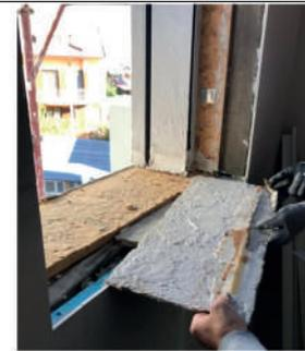
Errato posizionamento di un infisso. Assenza di soglia in pietra, sostituita da elemento in fibra di legno con finta soglia in alluminio
